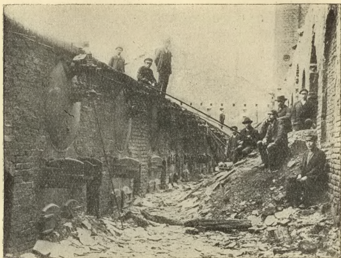
Widok spalonej kotłowni.
