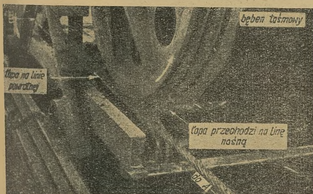
Rys. 4. Dołączenie taśmy nośnej do lin
