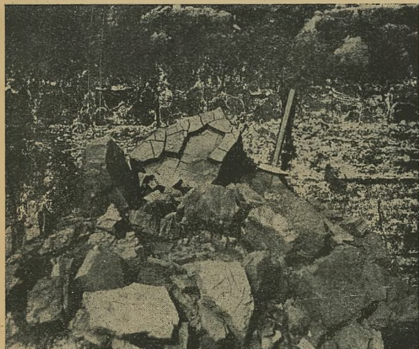
Rys. 11. Spekania warstw zewnętrznych powstałe w wyniku wypychania mułów
