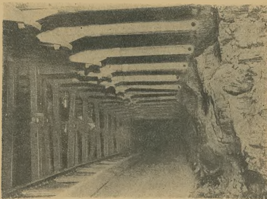
Rys. 1. Ściana obudowana polskimi stropnicami członowymi
