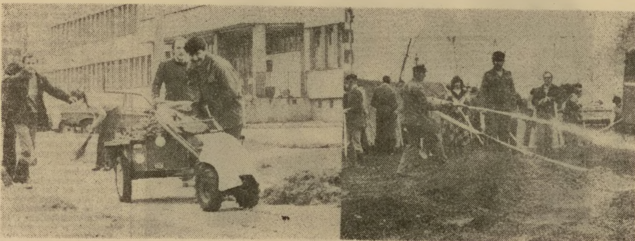
Pracownicy GZOZ-u porządkowali teren wokół Szpitala Górniczego, zaś przedstawiciele załogi KWK „Moszczenica” budowali kompleks obiektów sportowych przy ul. Podhalańskiej. Zdjęcia: J. Zak
