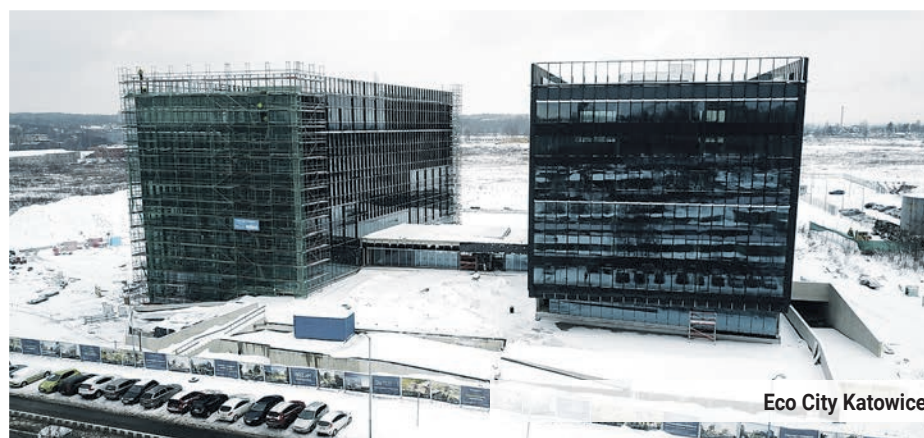
Modernizacja budynku przy ul. Bankowej 5
