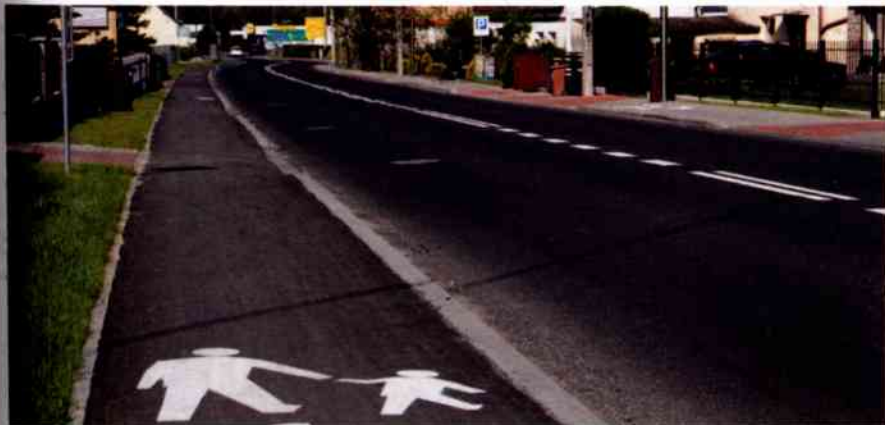
Odcinek DW 409 w Gogolinie, na którym prowadzone były prace modernizacyjne.
