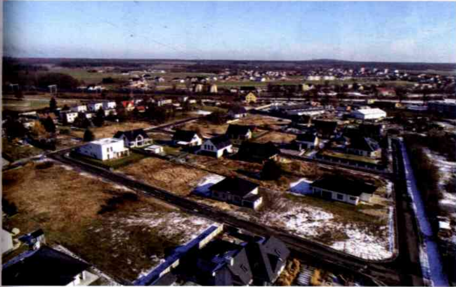
Wyremontowane ulice Norwida i Hudalli.
