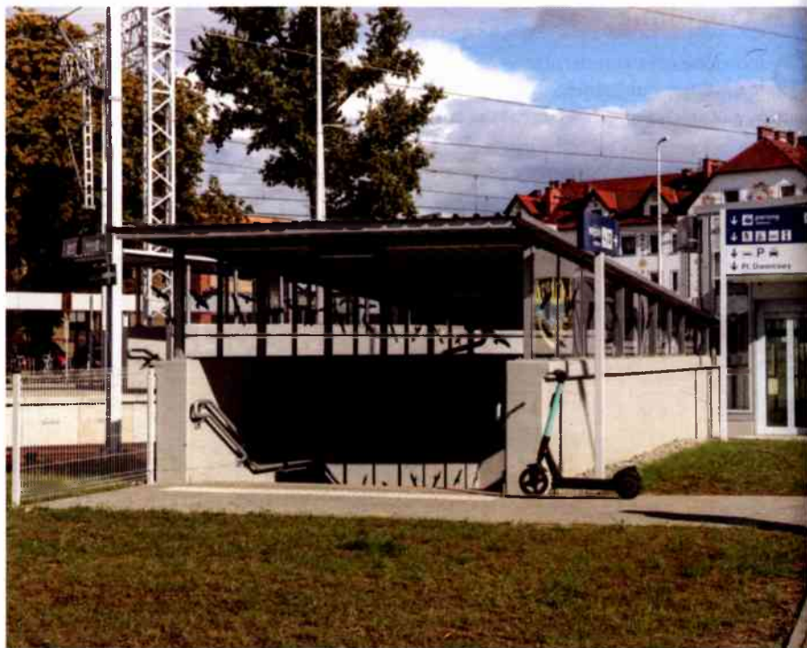
Mieszkańcy Gogolina już korzystają z przejścia podziemnego.
