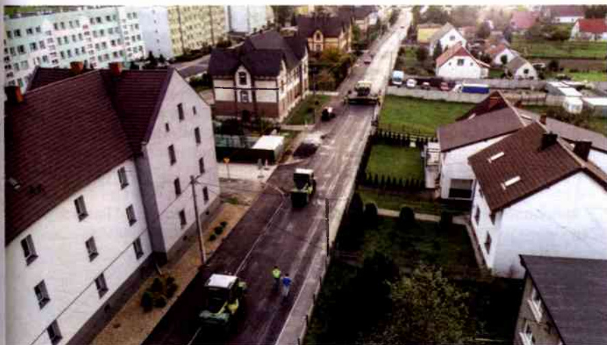
Remont ulicy Powstańców obejmował m.in. wymianę nawierzchni oraz wykonanie ścieżki pieszo-rowerowej.
