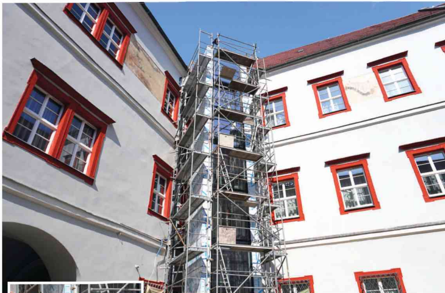
Budowa windy w Muzeum Powiatowym w Nysie
