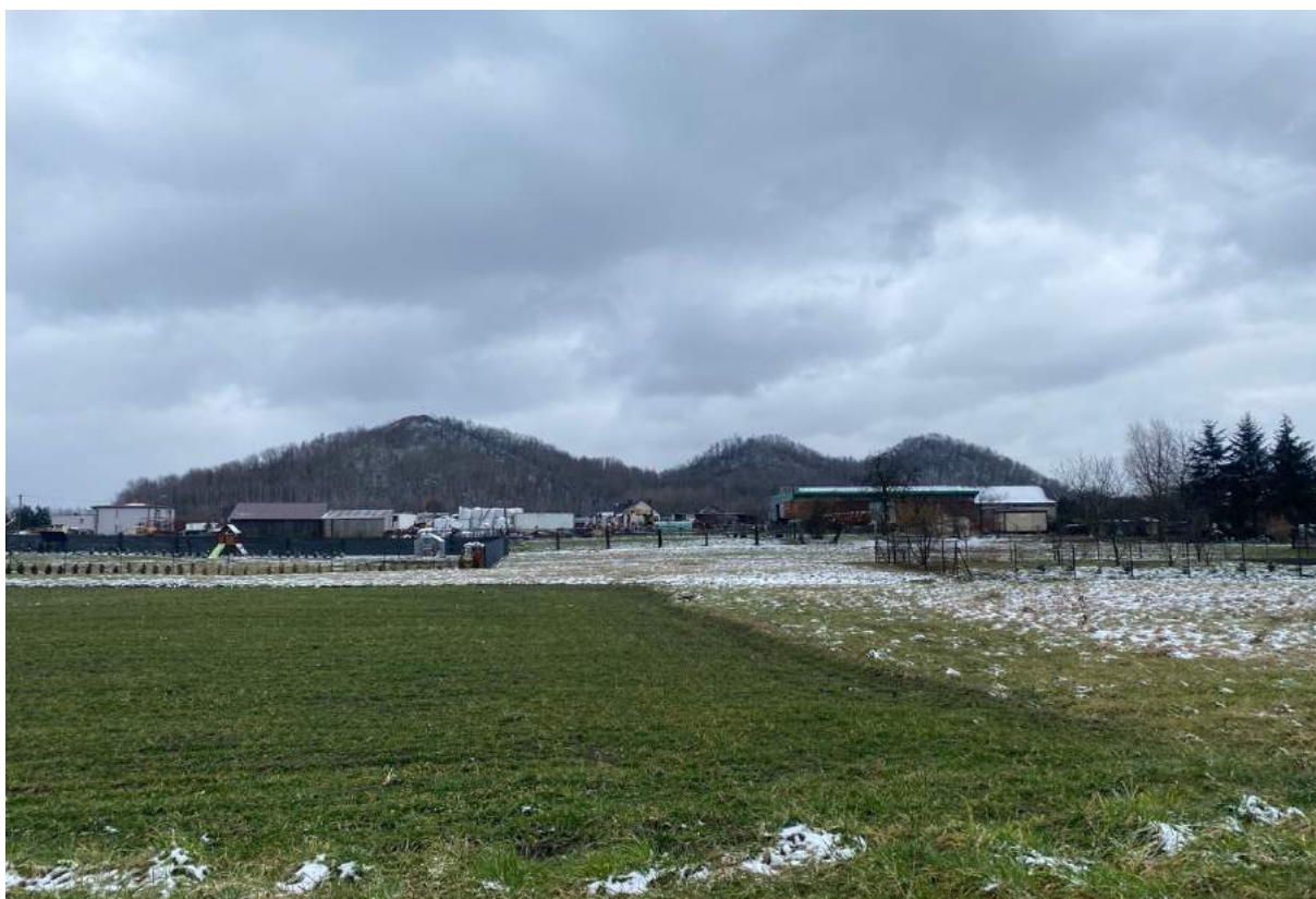
Fot. 11. Czerwionka-Leszczyny dzielnica Dębieńsko – nieczynne hałdy kopalni „Dębieńsko” widok w kierunku wschodnim
