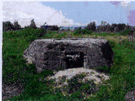
Goczałkowice. Pozostałość po FuMG-65.
