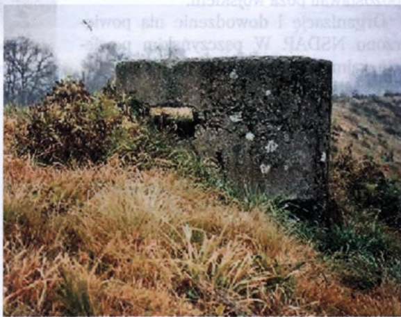
Kochbunker, pozostałość umocnień przy wale Wisły w Jedlinie.
