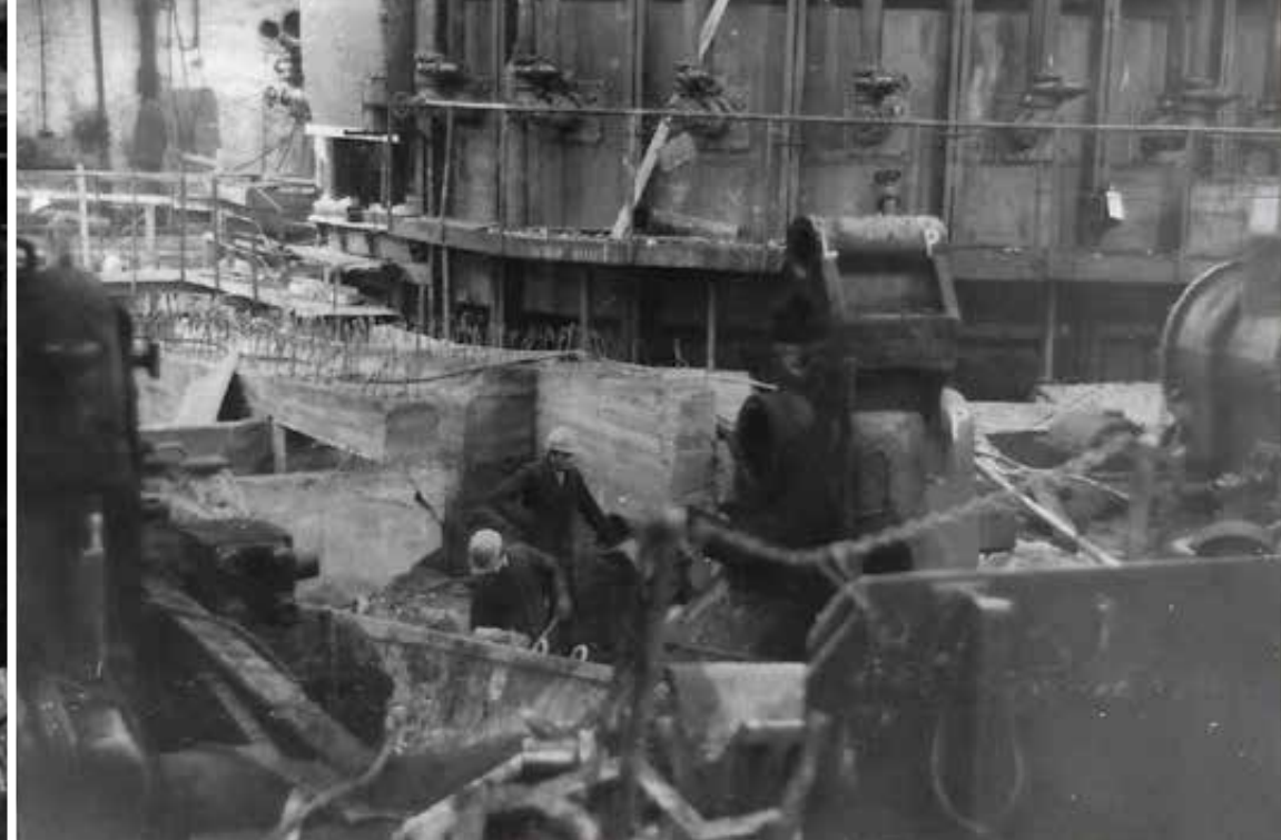
Dokumentacja fotograficzna z postępu prac związanych z budową walcarki pielgrzymowej w walcowni rur, 1969/1970 rok, autor nieznany, zbiory prywatne.
