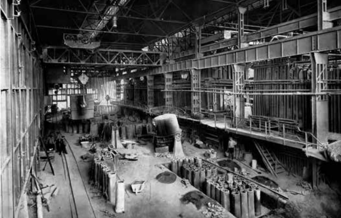
Powyżej: widok ogólny hali lejniczej stalowni martenowskiej, lata 20. XX wieku, Śląska Biblioteka Cyfrowa. Poniżej: jeden z ciągów technologicznych walcowni cienkiej blachy, lata 20. XX wieku, Śląska Biblioteka Cyfrowa.
