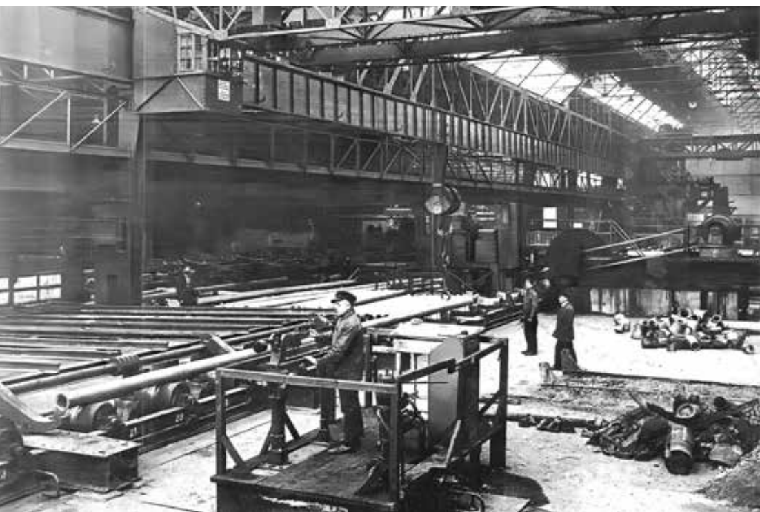
Powyżej: walcarka pielgrzymowa zespołu MM III walcowni rur, 1930 rok, fot. Max Steckel, Śląska Biblioteka Cyfrowa. Poniżej: waga oraz piła do cięcia rur wchodzące w obręb walcowni rur, 1930 rok, fot. Max Steckel, Śląska Biblioteka Cyfrowa.
