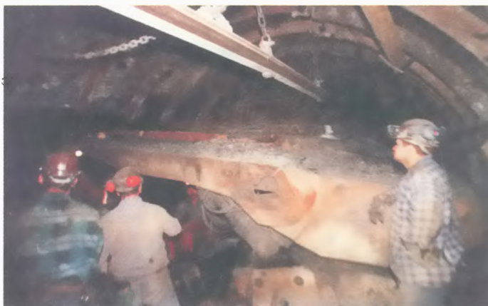
Rys.4. Faza ustawiania sekcji obudowy zmechanizowanej po wypięciu łuku ociosowego, urobieniu calizny węglowej i wzmocnieniu stropu
