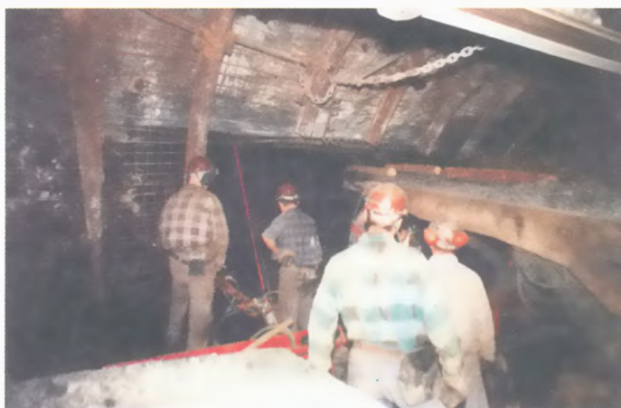
Rys.5. Faza wzmacniania krawędzi stropu chodnika za pomocą kotwi dla jego późniejszego utrzymania po zabudowie pasa podporowego
