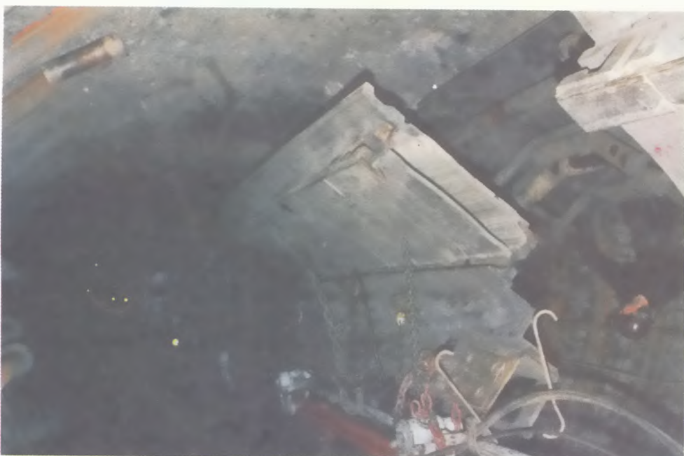
Rys.15. Sposób transportu zespołu przenośnika ścianowego zgrzeblowego
