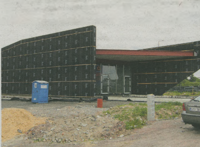
Na budowie pawilonu nie ma żywej duszy
