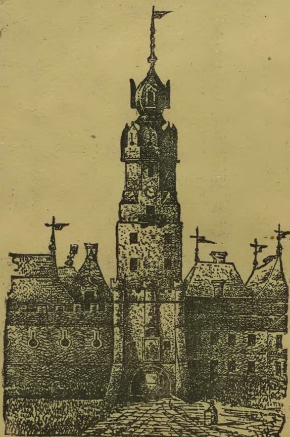
Bramą krakowską w Lublinie. zbudowana w roku 1342 przez Kazimierza Wielkiego.
