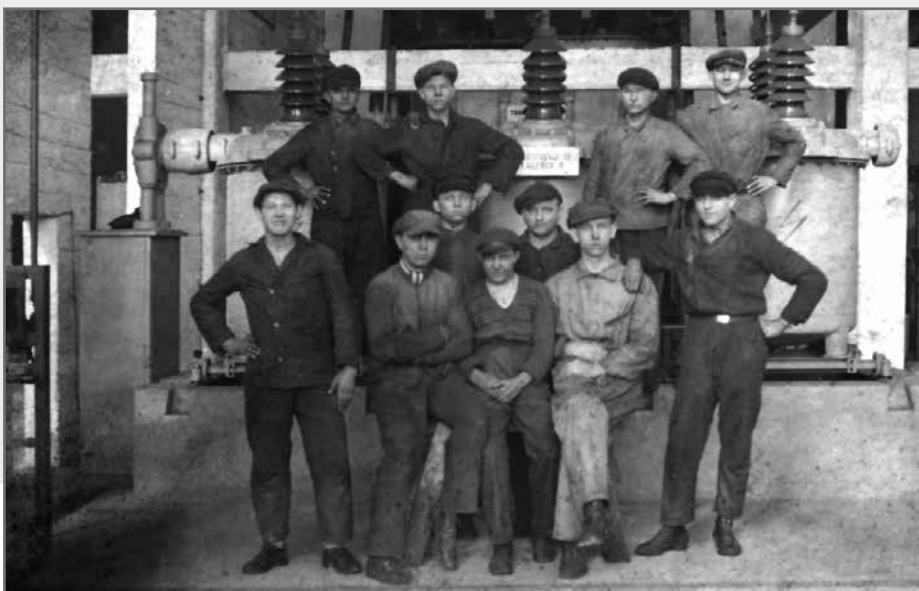
Grupa robotników w rozdzielni 60 kV, koniec lat 30. XX w. Ze zbiorów Muzeum Energetyki w Łaziskach Górnych
