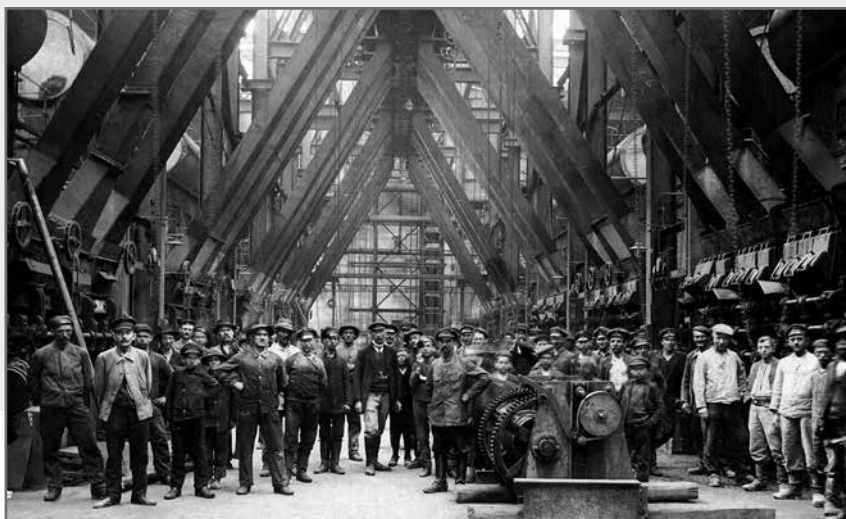
Pracownicy hali kotłowej 15 atmosfer. 1. połowa lat 20. XX w. Ze zbiorów Muzeum Energetyki w Łaziskach Górnych
