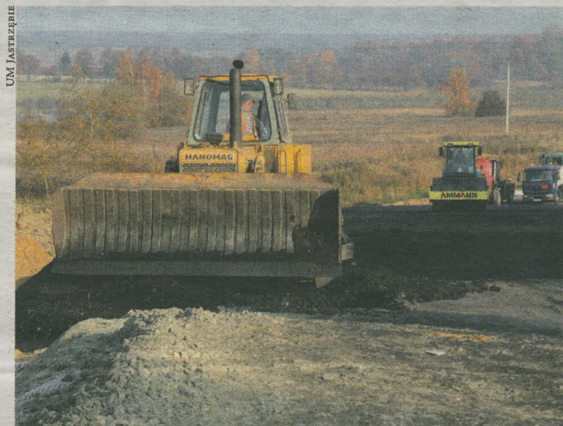
Budowa pierwszego odcinka jest na półmetku
