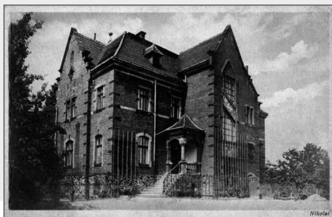
Różne zdjęcia willi dr. H. Zeumera przy dzisiejszej ul. Katowickiej 22. Powyżej kartka nadana 23 listopada 1914r. z Mikołowa do adresata w Neudorf (Nowa Wieś; obecnie Wirek, dzielnica Rudy Śląskiej). Poniżej kartka pocztowa z 1. połowy lat 40. XX wieku. Obie ze zbiorów Piotra Grodeckiego
