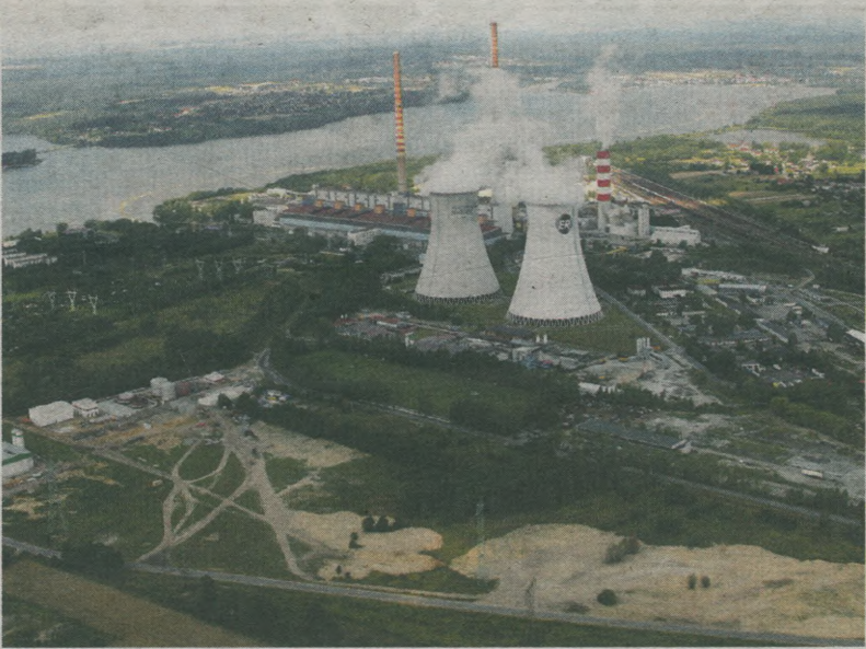
Za parę lat w rybnickiej elektrowni pojawi się nowy blok energetyczny
