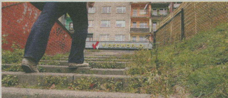
Tak wyglądały schody w październiku...
