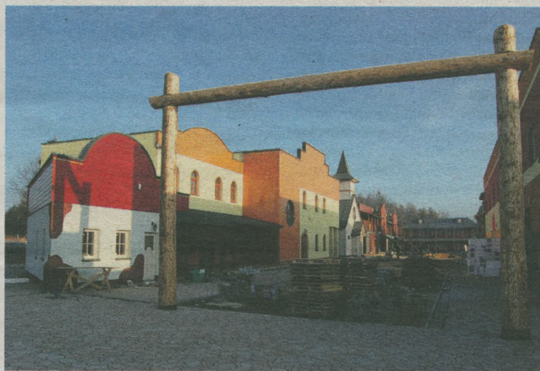
Roboty budowlane w miasteczku westernowym zakończą się jeszcze w grudniu
