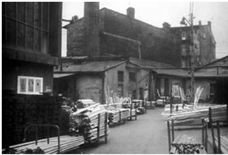
Budoplast, lata 60. XX w., w tle budynki przy ul. S. Stojałowskiego 48 portal Beskidia.pl
