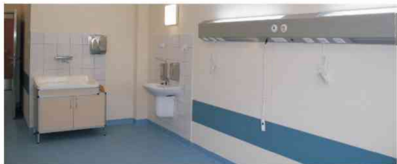
Segment na Oddziale Położniczym składający się z 2-osobowego pokoju i indywidualnej łazienki. Wyposażony jest w panel z gazami medycznymi, instalację oświetlenia dziennego i nocnego, instalację przyzywową oraz wanienkę do pielęgnacji noworodka.
