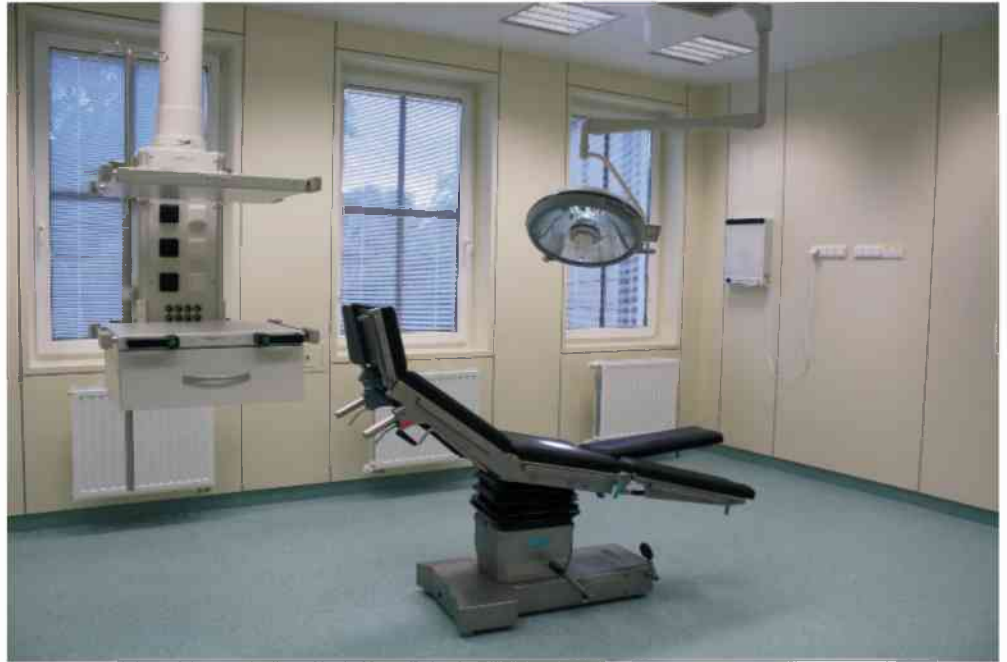
Sala operacyjna. Ściany wykonane są z paneli z blachy nierdzewnej pomalowanej proszkowo farbą zawierającą bakteriobójcze jony srebra. Panele połączone są hermetycznymi uszczelkami. Sufit panelowy z blachy nierdzewnej malowanej proszkowo bakteriobójczą farbą z jonami srebra na hermetycznych uszczelkach. Podłoga pokryta antystatyczną i bakteriobójczą wykładziną. Okna z PCV z międzyszybowymi żaluzjami. Sala wyposażona jest w indywidualną wentylację mechaniczną z klimatyzacją wytwarzającą nadciśnienie wykluczające możliwość mieszania się powietrza z innych części szpitala. Realizowane jest to przez sufitowe laminarne systemy nawiewne z filtrami absolutnymi. Do sali doprowadzone są gazy medyczne: tlen, próżnia, powietrze i podtlenek azotu. Sala wyposażona jest w najnowocześniejszy stół operacyjny PRELUDIUM, negatoskop ścienny, anestezjologiczną kolumnę sufitową z napędem powietrznym oraz sufitową, wieloramienną lampę operacyjną.
