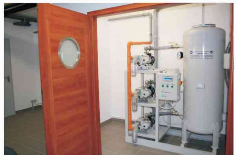
Pomieszczenie techniczne wyposażone w 3 pompy do wytwarzania próżni w systemie zapewniającym bezpieczeństwo w sytuacji zwiększonego poboru lub awarii.
