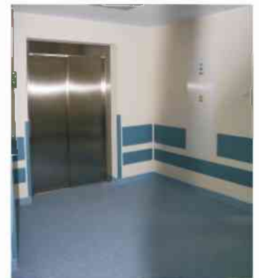
Hol z windą na Oddziale Noworodkowo - Położniczym. Winda wykonana w technologii blachy nierdzewnej z napędem hydraulicznym.
