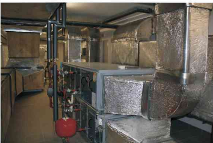
Stacja wentylacji mechanicznej obsługująca kondygnację budynku szpitala. Wyposażona jest w system odzysku ciepła poprzez wymienniki. Powietrze jest podgrzewane, chłodzone i filtrowane przez system filtrów.
