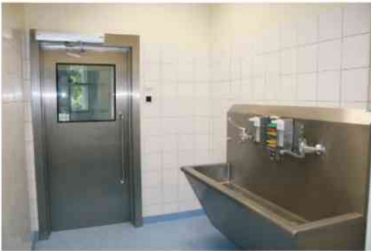
Myjnia chirurgiczna dla lekarzy przed salą operacyjną. Wyposażona jest w nierdzewne urządzenie zlewowe wraz z dezynfektorami. Drzwi do sali operacyjnej wykonane są z blachy nierdzewnej, kwasoodpornej i otwierane są w systemie bezdotykowym na fotokomórkę.
