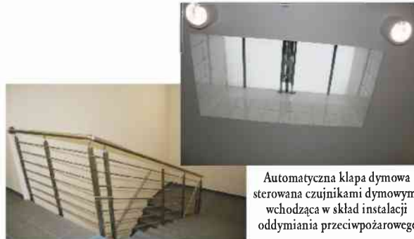
Klatka schodowa w wydzielonej strefie pożarowej wyposażona w nierdzewne barierki, płytki gresowe, antypoślizgowe. Klatka wraz z instalacją oddymiania przeciwpożarowego spełnia funkcję ewakuacyjną.
