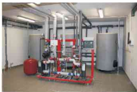
Pomieszczenie techniczne, w którym znajduje się wymiennikownia ciepła. Ciepło dostarczane jest z zewnętrznej ciepłowni, wykorzystywane jest do ogrzewania budynku oraz do wytwarzania ciepłej wody. Woda gromadzona jest w 3 zbiornikach wyposażonych w dodatkowe rezerwowe zasilanie elektrycznymi grzałkami.
