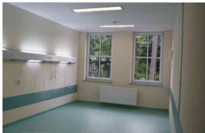
Oddział Pediatryczny, sala dzieci młodszych wyposażona w panel z gazami medycznymi, instalację oświetlenia dziennego i nocnego oraz w instalację przyzywową. Sala wentylowana jest poprzez mechaniczną wentylację nawiewno – wywiewną.
