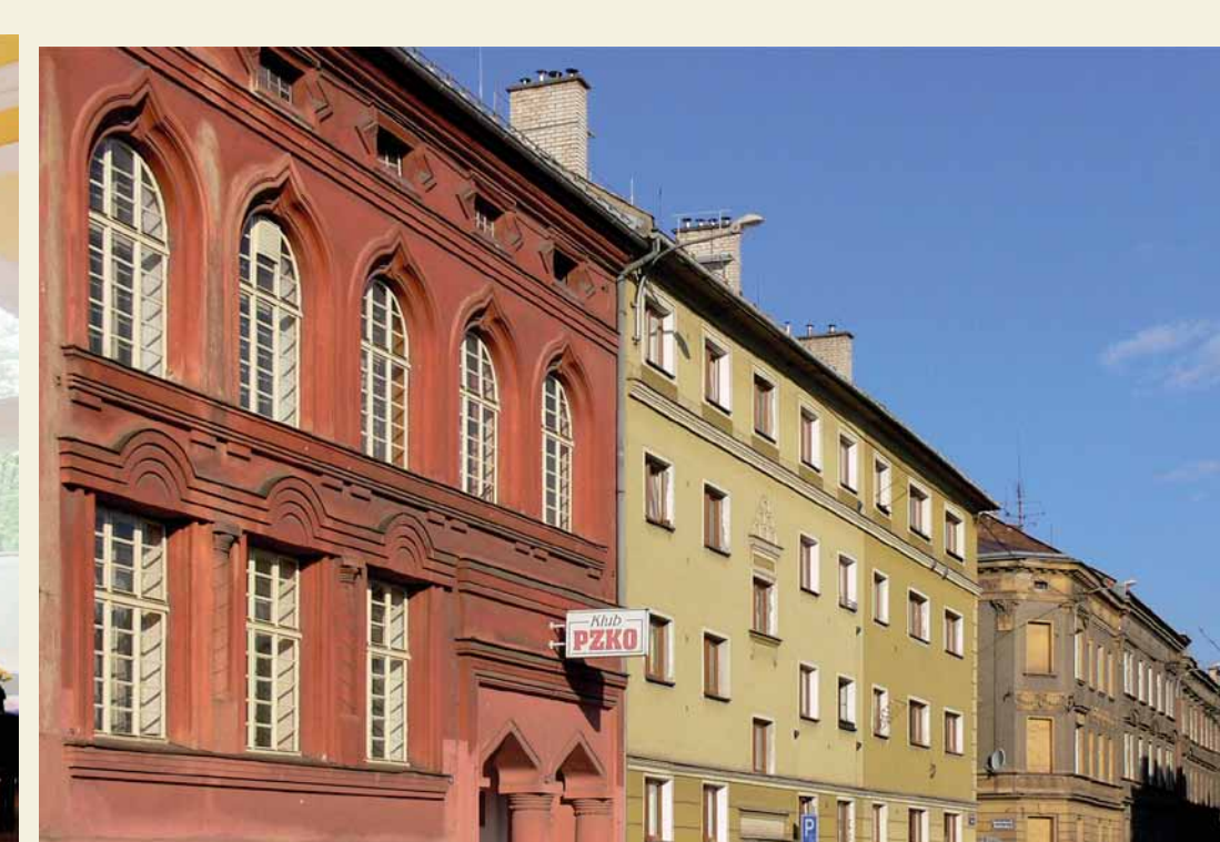
Świetlica MK PZKO w Czeskim Cieszynie-Centrum mieści się w budynku ZG PZKO przy ul. Bożka
