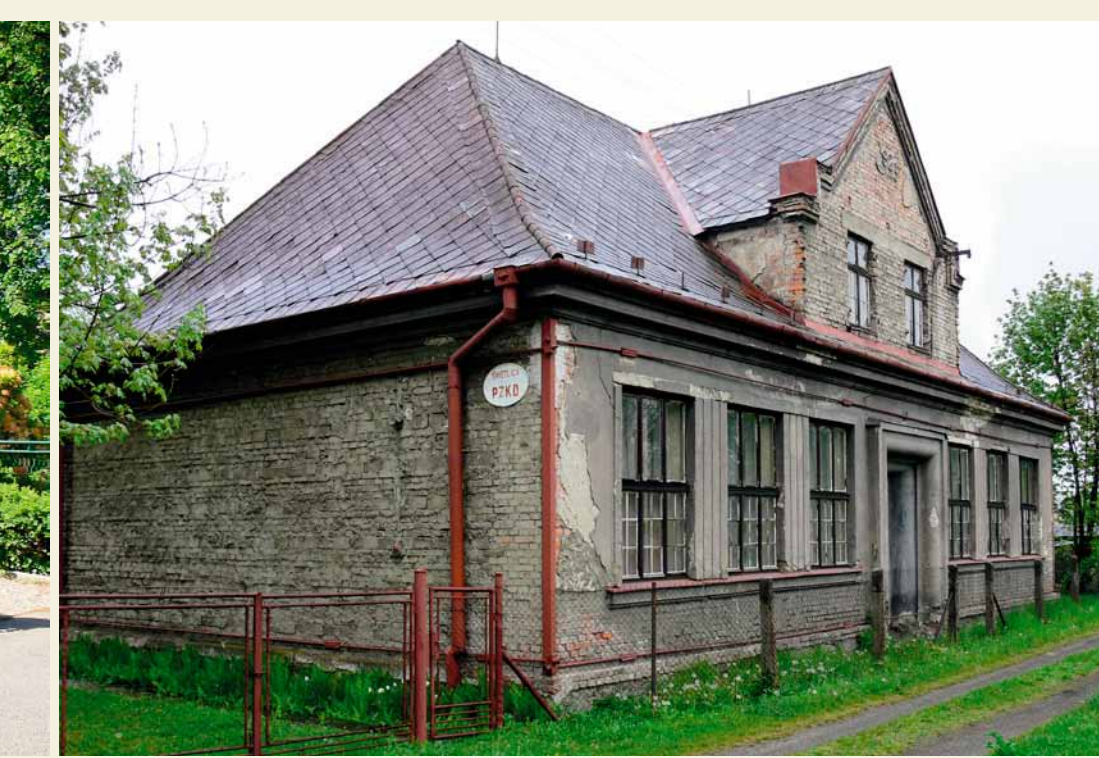
Świetlica PZKO w Karwinie-Sowińcu
