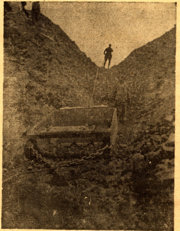
Der Schrapper beim Abräumen einer Berghalde
