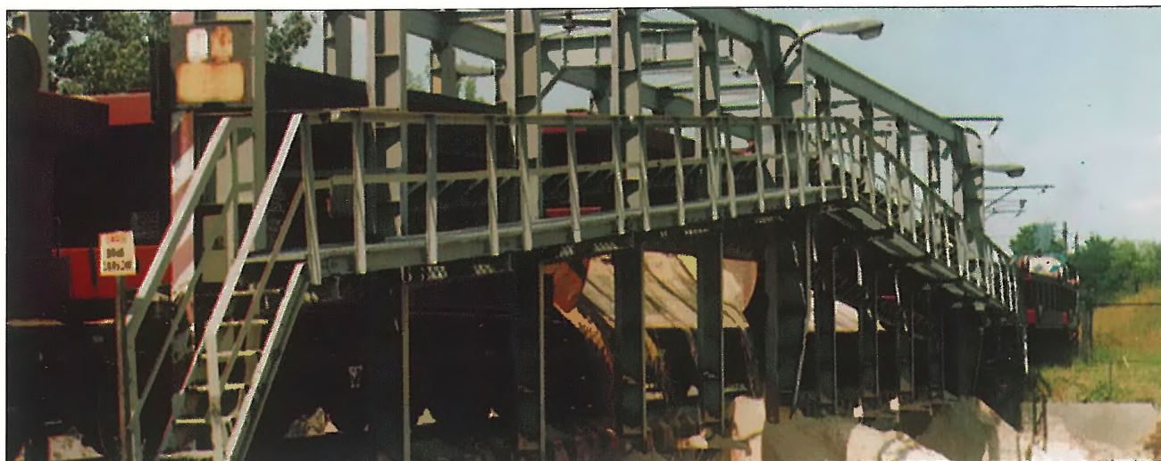
Wyładunek piasku na moście samowyładowniczym
