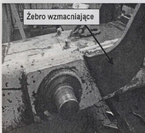
Rys.2.4. Wzmocnienie konstrukcji wysięgnika
