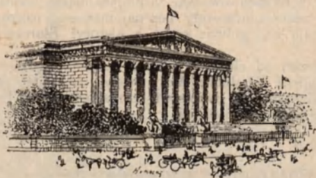
Gmach Izby Deputowanych.
