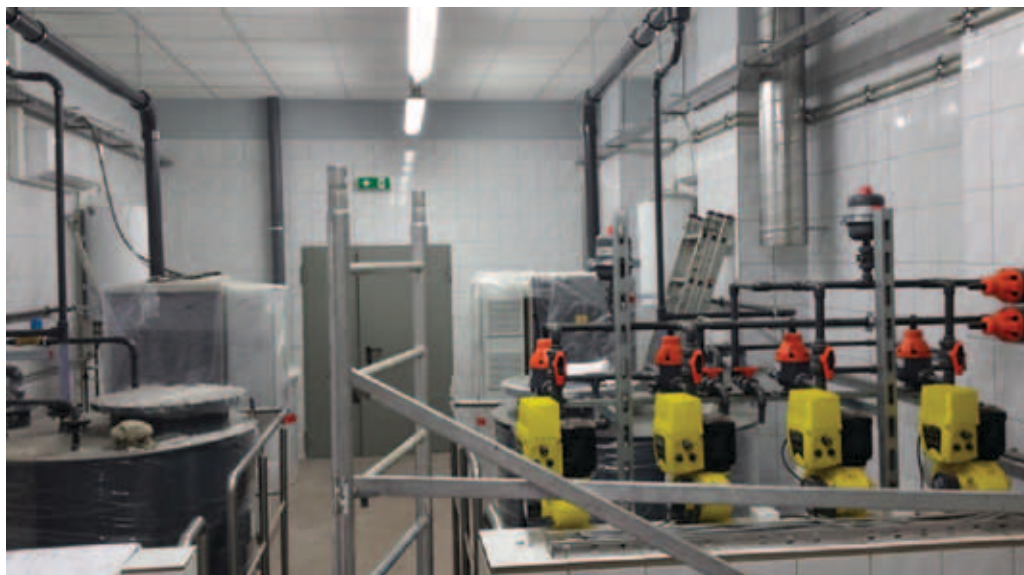
Rysunek 57. SUW SOŁA I w Kobiernicach. Końcowe prace przy budowie stacji dezynfekcji wody opartej na wytwarzaniu podchlorynu sodu w procesie elektrolizy soli kuchennej [źródło: materiały archiwalne AQUA S.A.].
