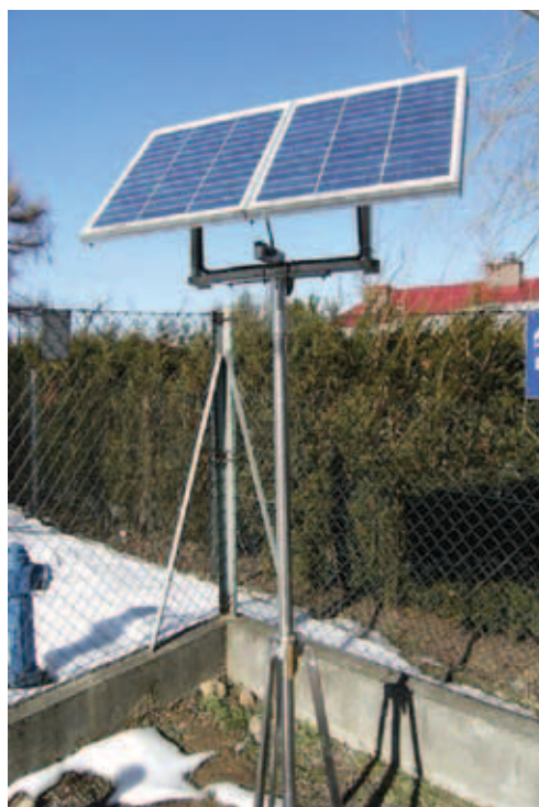
Rysunek 106. przedstawia przebieg procesów technologicznych istotnych dla utrzymania zasilania urządzeń kontrolno-pomiarowych zabudowanych na sieciach wodociągowej i kanalizacyjnej AQUA S.A. zasilanych z akumulatorów i układu akumulatorów paneli.
