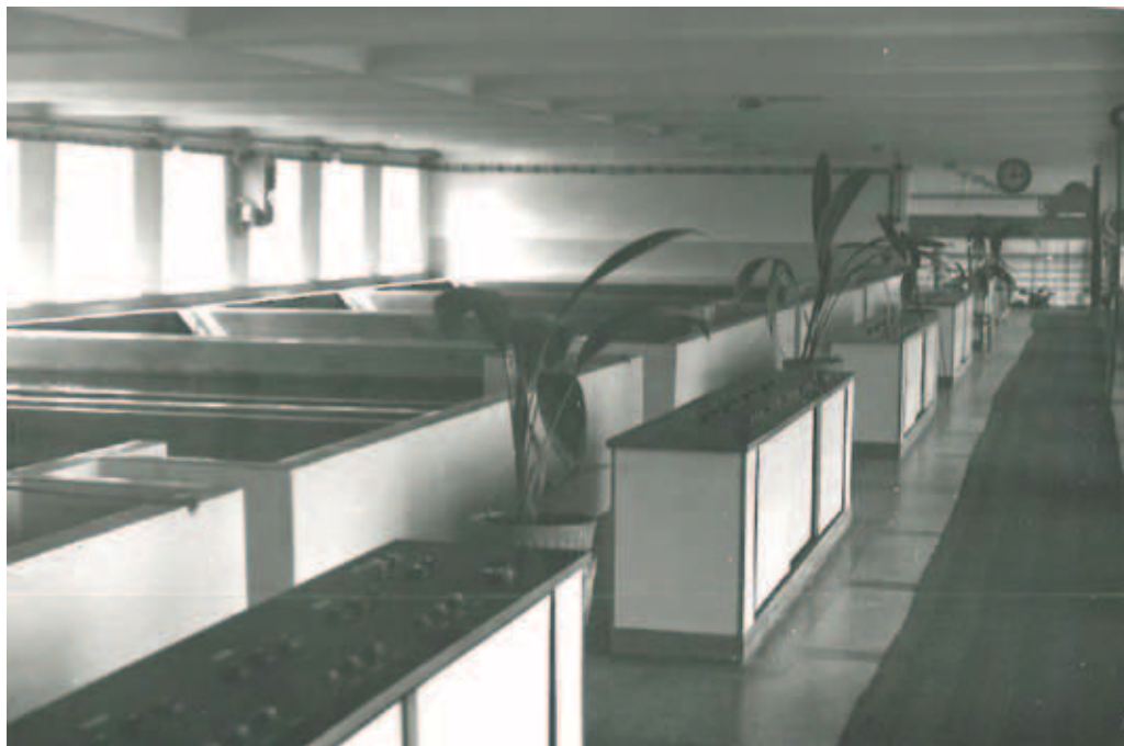
Rysunek 45. Filtry pośpieszne (w głębi) i pulpity sterownicze (na pierwszym planie) zbudowane w Kobiernicach na SUW SOŁA I i uruchomione po raz pierwszy w 1953 r. [źródło: Wojciechowski, 1974].
