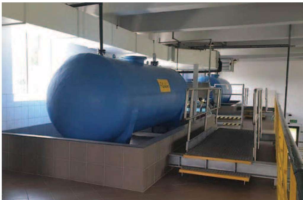
Rysunek 52. Cysterny z płynnym koagulantem FLOKOR w budynku koagulacji [źródło: materiały archiwalne AQUA S.A.].
