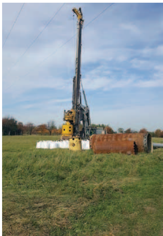
Rysunek 27. Palownica w trakcie wykonywania w roku 2017 otworu dla potrzeb zabudowy szerokodymensyjnej studni infiltracyjnej z filtrem szczelinowym Johnson'a [źródło: materiały archiwalne AQUA S.A.].
