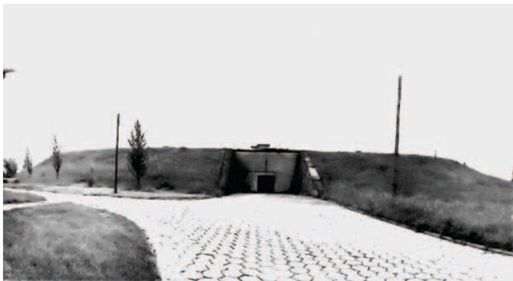
Rysunek 43. Widok na dwa zbiorniki wodociągowe (retencyjno-wyrównawcze) w Lipniku. Stan z roku 1973 [źródło: Wojciechowski, 1974 r.].
