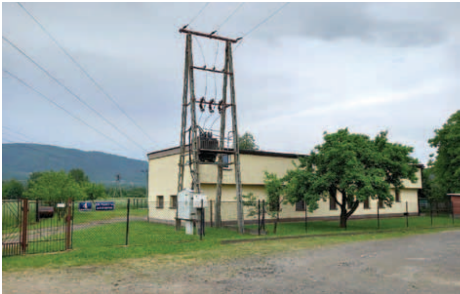
Rysunek 77. Widok na budynek byłej pompowni wody z młynówki Czanieckiej do Andrychowa wraz ze stacją TRAFO. Pompownia działała zgodnie z pierwotnym projektem w latach 1978–1984 [źródło: materiały archiwalne AQUA S.A.].
