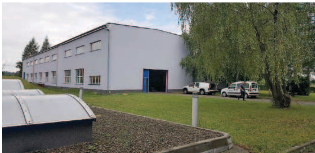
Rysunek 104. Widok od strony warsztatu na budynek pompowni G w Kobiernicach po termomodernizacji (ujęcie SOŁA III/1). Na pierwszym planie podziemna komora, w której zabudowano lampy UV do fizycznej dezynfekcji wody uzdatnionej przed procesem dezynfekcji chemicznej przy pomocy podchlorynu sodu oraz pompowaniem do magistralnej sieci wodociągowej AQUA S.A. [źródło: materiały archiwalne AQUA S.A.]
