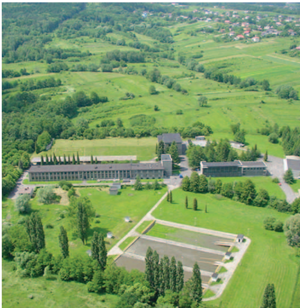
Rysunek 49. Widok obiektów stacji uzdatniania wody SOŁA I w Kobiernicach [źródło: materiały archiwalne AQUA S.A.].
