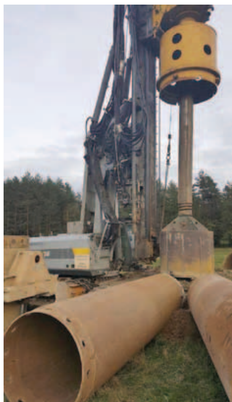
Rysunek 28. Palownica w trakcie budowy zamiennej studni infiltracyjnej na ujęciu SOŁA II w Kobiernicach w 2017 r. [źródło: materiały archiwalne AQUA S.A.].
