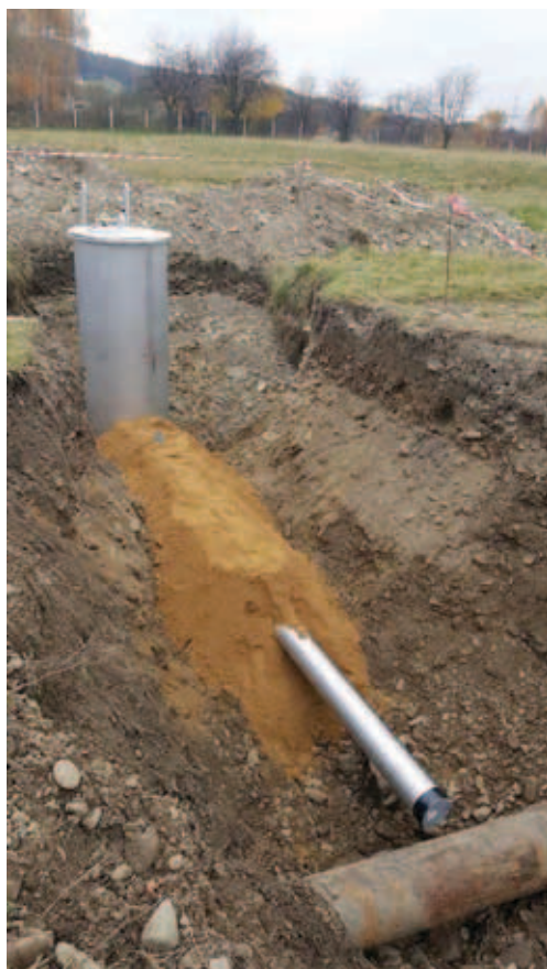
Rysunek 29. Nowa studnia infiltracyjna na ujęciu SOŁA II w Kobiernicach w trakcie podłączania do grawitacyjnego lewara A [źródło: materiały archiwalne AQUA S.A.].
