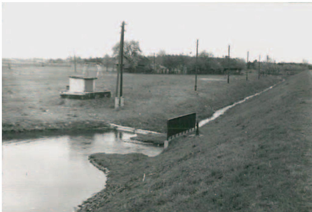
Rysunek 19. Ujęcie SOŁA II. Pierwsze ujęcie wody ze zbiornika Czaniec do nawadniania stawów infiltracyjnych (rok 1973) [źródło: materiały archiwalne AQUA S.A.].
