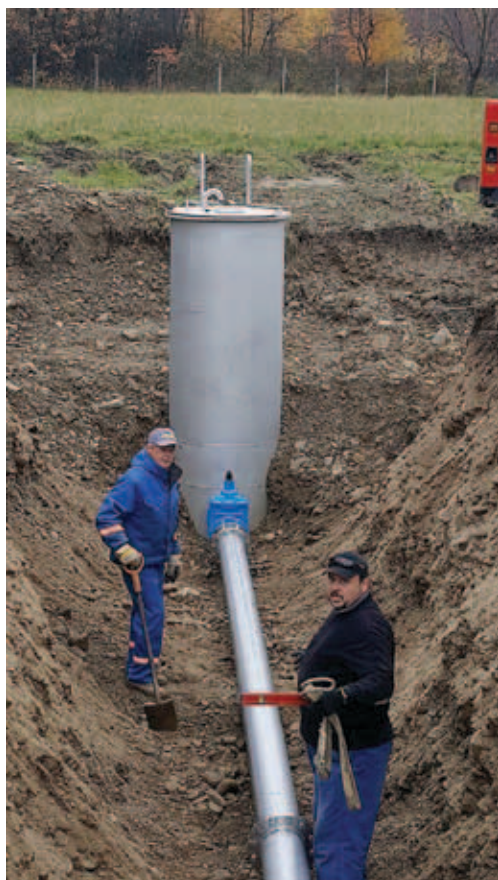
Rysunek 29. Nowa studnia infiltracyjna na ujęciu SOŁA II w Kobiernicach w trakcie podłączania do grawitacyjnego lewara A [źródło: materiały archiwalne AQUA S.A.].
