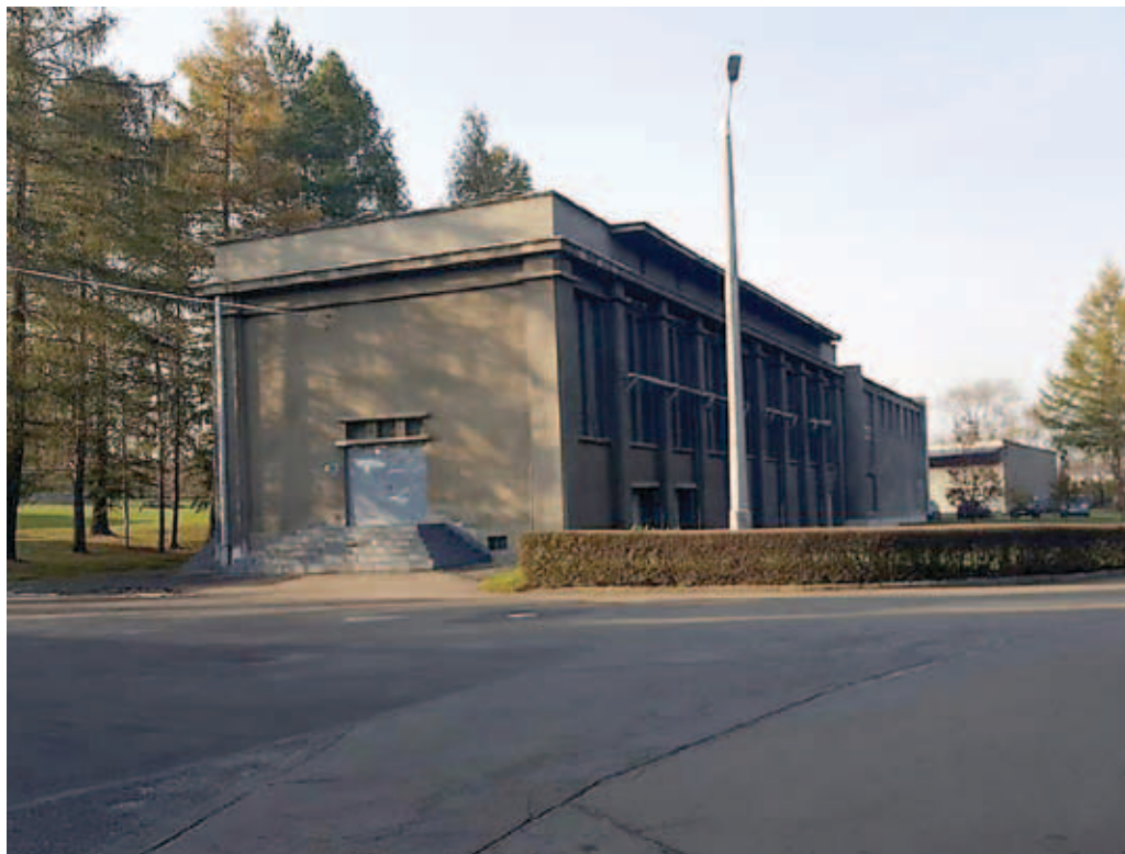
Rysunek 94. Budynek najstarszej rozdzielni elektrycznej i stacji transformatorowej na SOŁA I w Kobiernicach [źródło: materiały archiwalne AQUA S.A.].
