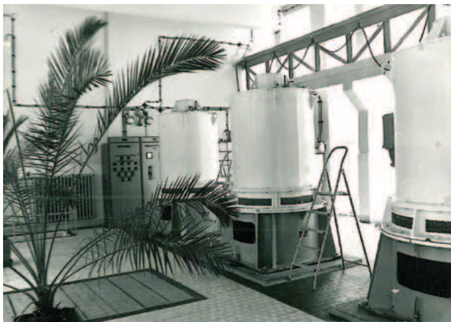
Rysunek 76. Pompownia wysokiego ciśnienia zbudowana na potrzeby pompowania wody z ujęcia SOŁA II [źródło: Wojciechowski, 1974].
