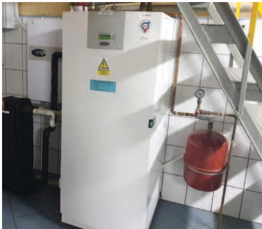
Rysunek 97. Widok pierwszej zabudowanej w 2004 r. w AQUA S.A. na pompowni A pompy ciepła [źródło: materiały archiwalne AQUA S.A.].
