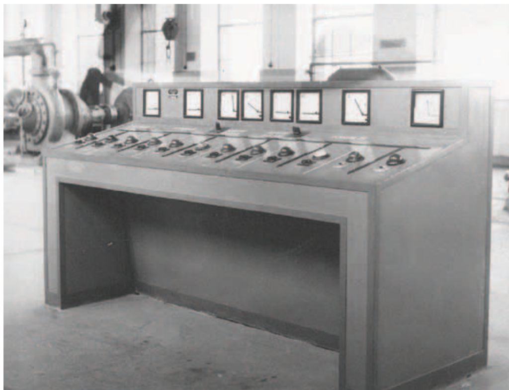
Rysunek 46. Pierwszy pulpit sterowniczy na stacji wodociągowej SOŁA I w Kobiernicach [źródło: Wojciechowski, 1974].
