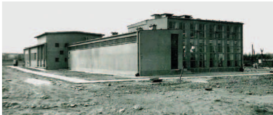
Rysunek 75. Budynek studni zbiorczej dla lewarów A i B ujęcia SOŁA II oraz pompowni niskiego i wysokiego ciśnienia wody na ujęciu infiltracyjnym w Kobiernicach. Stan w roku 1973 [źródło: Wojciechowski, 1974].
