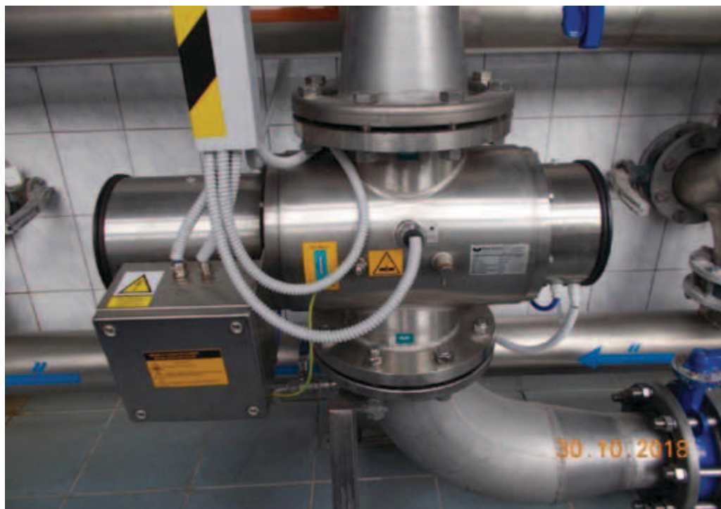
Rysunek 61. Lampa UV firmy BERTSON zabudowana na SUW w Szczyrku [źródło: materiały archiwalne AQUA S.A.].
