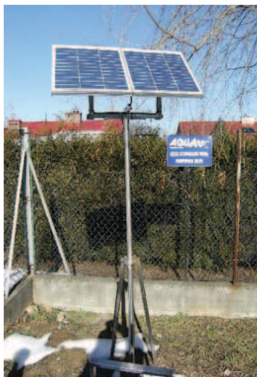
Rysunek 106. przedstawia przebieg procesów technologicznych istotnych dla utrzymania zasilania urządzeń kontrolno-pomiarowych zabudowanych na sieciach wodociągowej i kanalizacyjnej AQUA S.A. zasilanych z akumulatorów i układu akumulatorów paneli.
