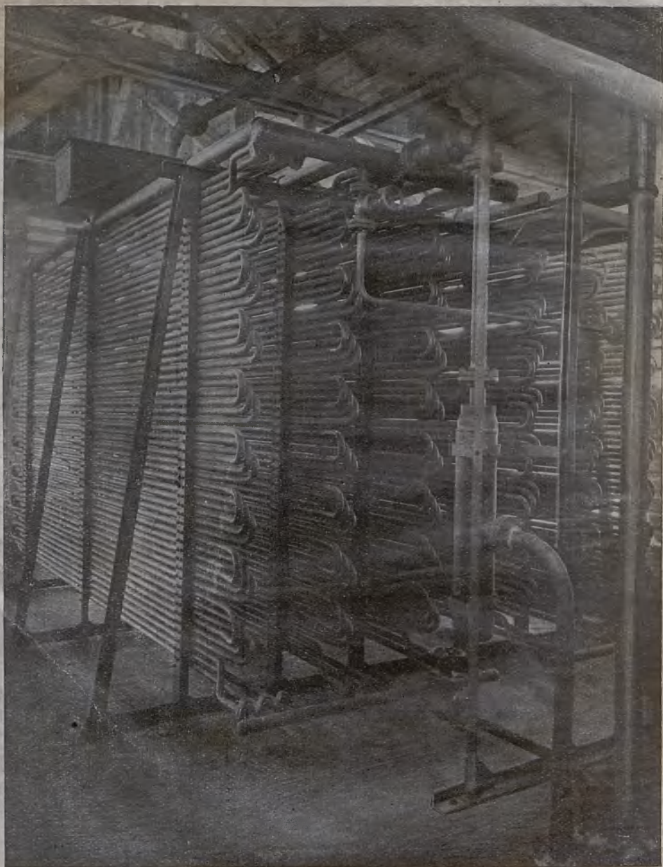
Kondenzator obciekowy pracuje z minimalnem zużyciem wody
