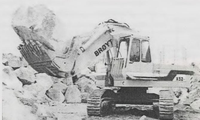
Rys.18. Załadunek urobku koparką hydrauliczną z osprzętem ładunkowym [7]
