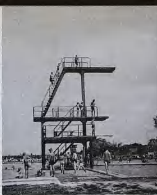
Skocznia stalowa (trampolina) przy pływalni w Katowicach
