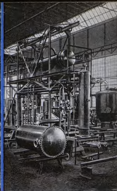
Urządzenie gazoliniarni w montażu we fabryce
