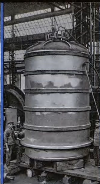
Warnik z żeliwa ługo- odpornego dla fabryki chemicznej
