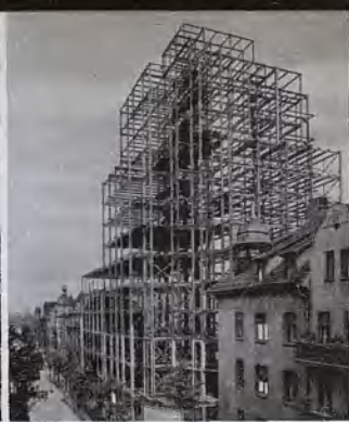
Szkielet stalowy budynku Urzędu Skarbowego w Katowicach
