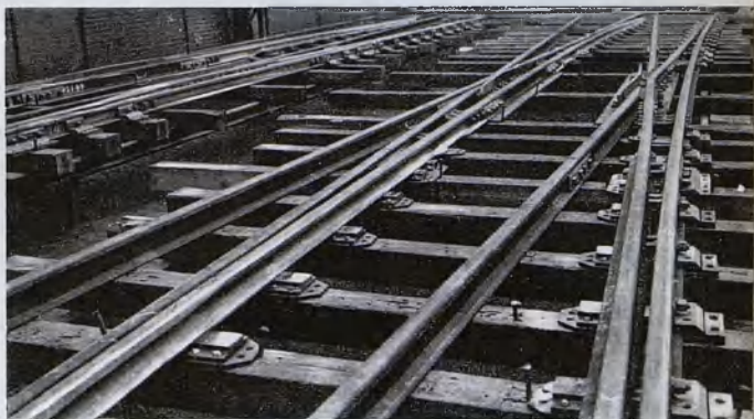
Rozjazd angielski poj. typu S z iglicami sprężystymi
