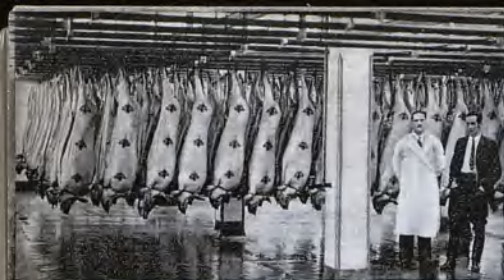
Chłodnia z kolejkami rurowymi w bekoniarni
