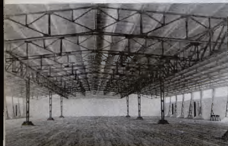
Hala o konstrukcji żelaznej
