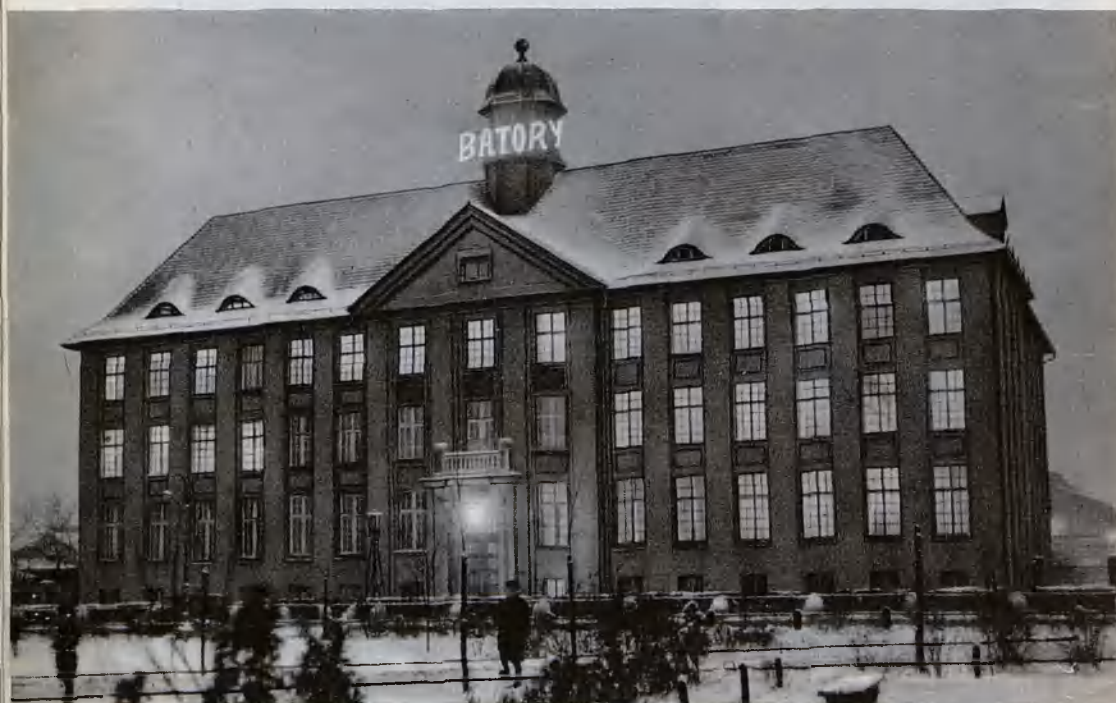
Siedziba Generalnej Dyrekcji Hut w Wielkich Hajdukach.
