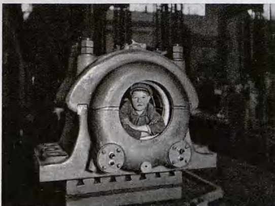
Łożysko z chłodzeniem
