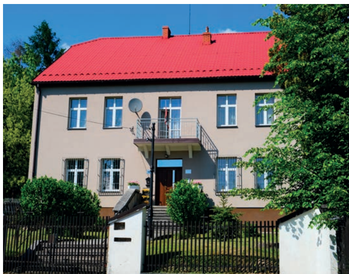
Budynek plebanii. Fot. Robert Matyskiel
