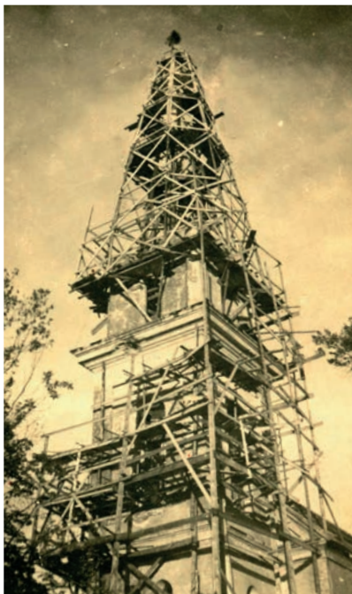
Odbudowa wieży kościelnej po zniszczeniach wojennych z 1945 r. Fot. z arch. Marty Dyby
