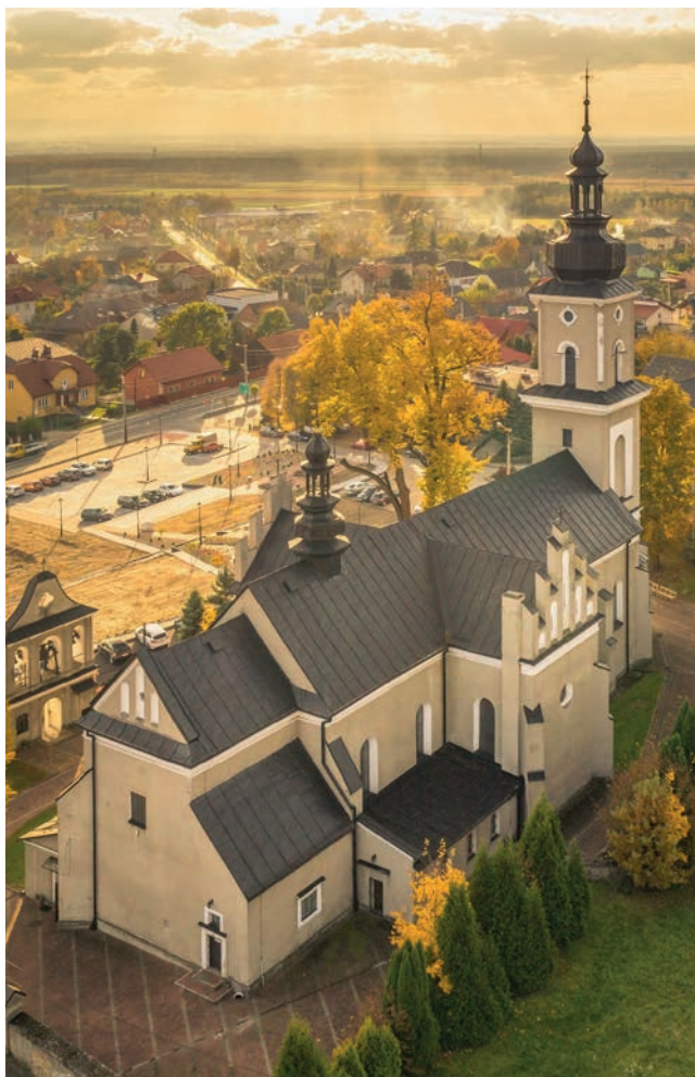
Dach kościoła parafialnego w Babicach po renowacji. Fot. Rafał Niebieszczański
