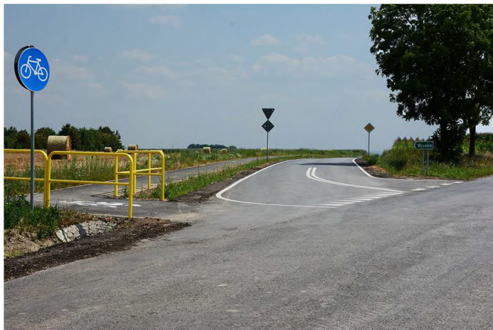
Droga po remoncie
