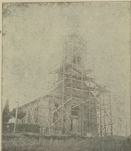
Budowa kościoła w Olbrachcicach.
