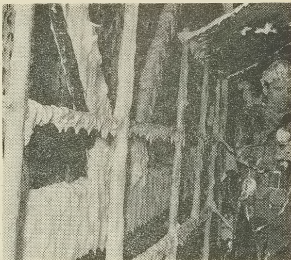
Rys. 4. Piana osadzona na elementach krzesła szybowego na poziomie 650 m
