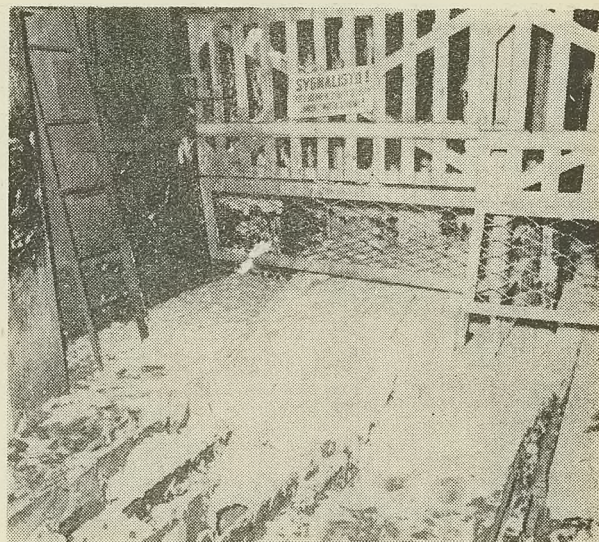
Rys. 5. Piana osadzona na pomostach wahadłowych na poziomie 850 m
