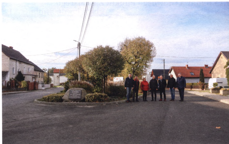
Plac Wiejski w Choruli po przebudowie.
