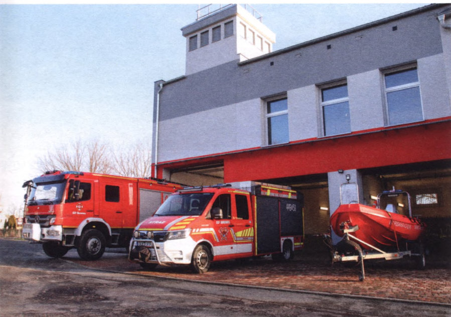
Remiza OSP Obrowiec po rozbudowie i termomodernizacji.
