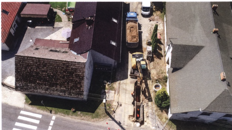
Budowa kanalizacji sanitarnej w Obrowcu.
