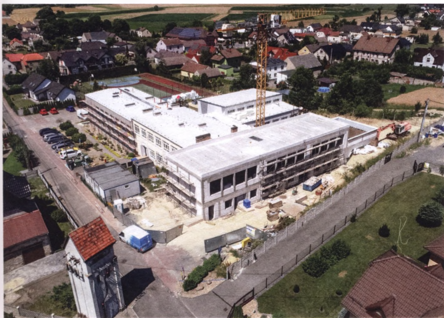
Szkoła w Malni w trakcie rozbudowy i termomodernizacji.
