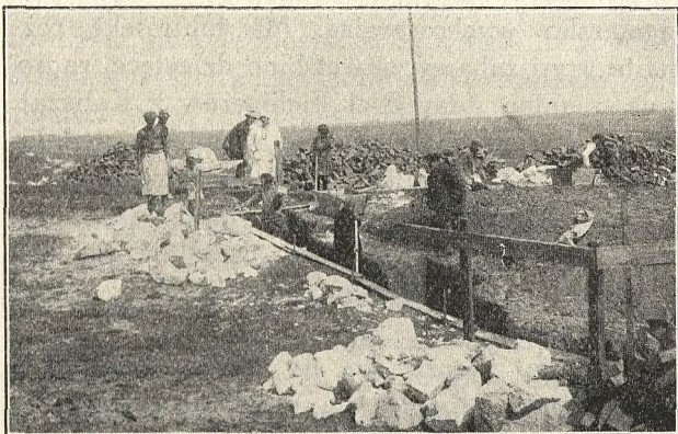
Budowa fundamentów pod „letnie pałacyki” w maju 1928 roku.
