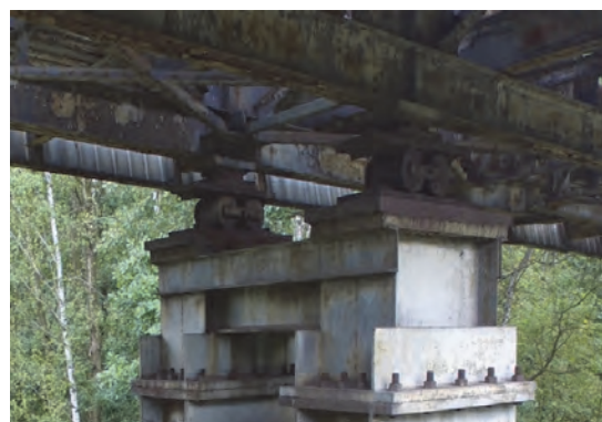
Fot. 9.5.8. Strefa oparcia przęsła pomostu estakady ciepłociągu na słupie (fot. P. Kalisz)
