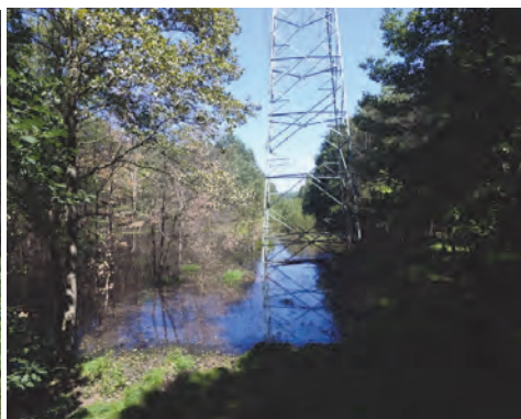
Fot. 9.5.9. Badany słup linii elektroenergetycznej WN (fot. P. Kalisz)
