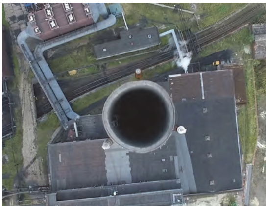
Fot. 9.5.7. Głowica kominu ciepłowni (Mika, Ferenc i Czaja, 2018)
