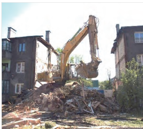
Fot. 4.4.1. Wyburzany segment w ciągu budynków
