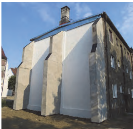
Fot. 4.4.2. Wykonane przypory po wyburzeniu segmentu
