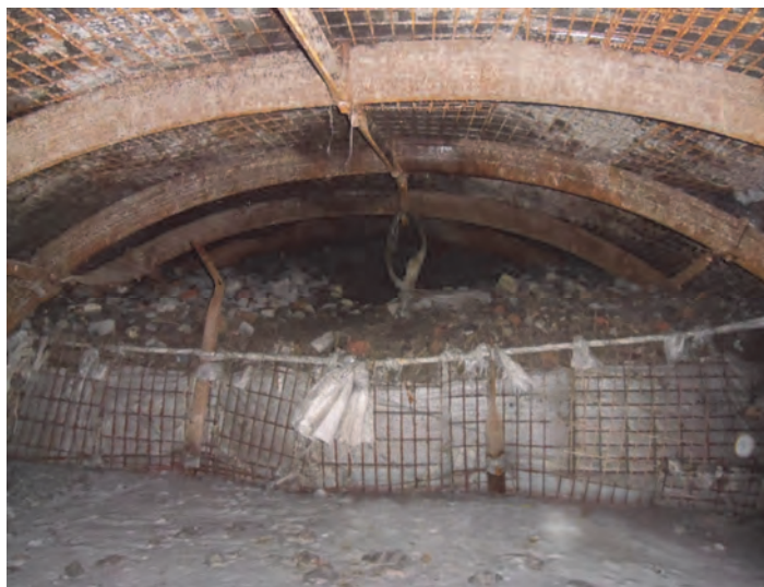
Fot. 4.5.1. Zlikwidowany chodnik eksploatacyjny wypełniony podsadzką z odpadów elektrownianych
