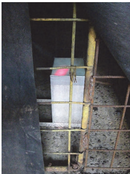
Fot. 9.3.2. Laserowo-komputerowy system pomiarowy monitoringu wychyleń wieży (Jaśkowski, 2018)
