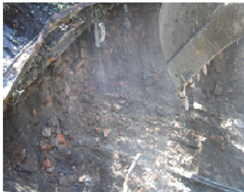
Fot. 3.7.2. Szyb Maria – odsłanianie płyty przykrywającej wylot szybu (fot. K. Kominowski)
