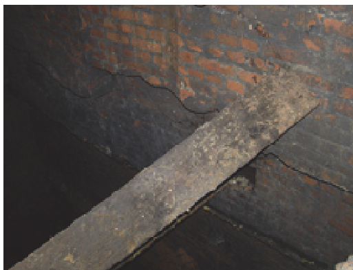
Fot. 3.7.3. Szyb Maria – niezasypany odcinek szybu pod płytą, na głębokości 7,0 m (fot. K. Kominowski)
