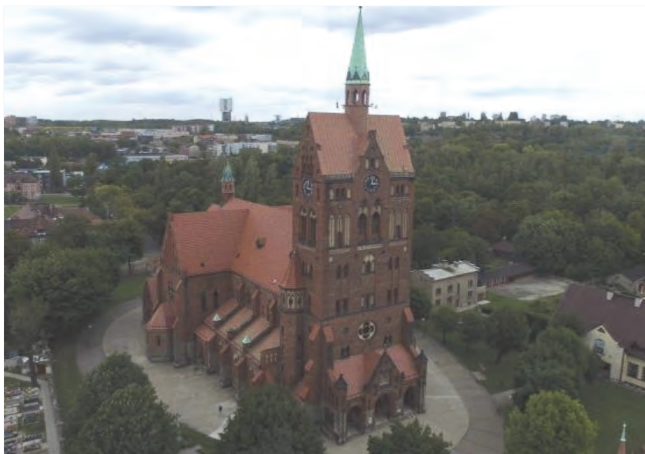
Fot. 9.5.1. Budynek kościoła w Rudzie Śląskiej-Wirku (Mika, Ferenc i Czaja, 2018)
