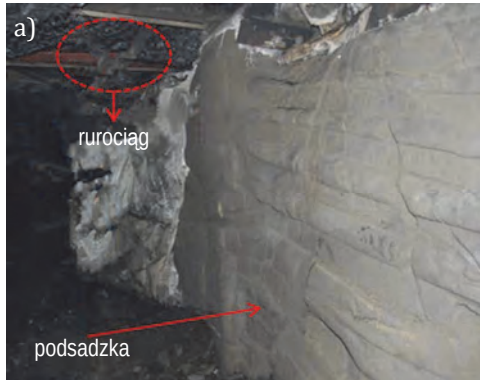
Rys. 2.5.10. Wpływ zastosowanej w kopalni Anshun technologii podsadzkowej – a na obniżenia powierzchni – b (Zhu i in., 2018)
