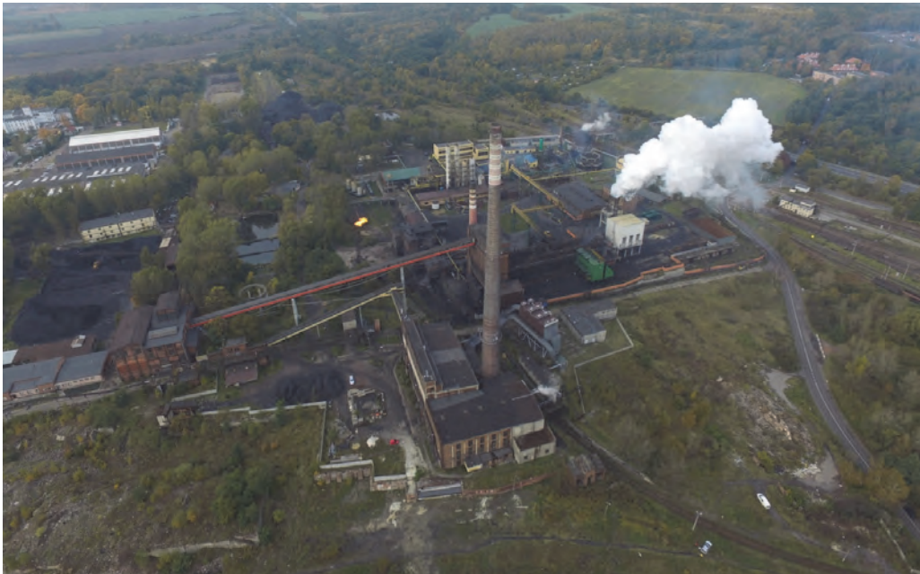
Fot. 4.5.1. Widok na koksonię i wysoki komin, pod którymi prowadzono eksploatację częściową
