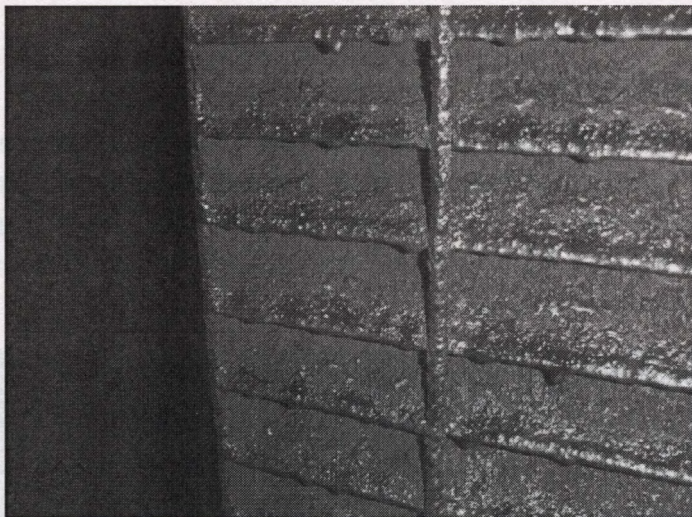
Rys. 7.28. Pył osiadły na kratkach żaluzyjnych [56]
