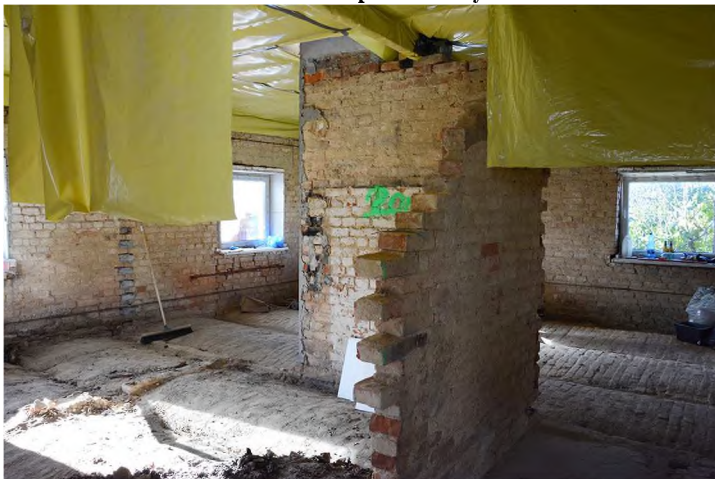
W trakcie przebudowy
