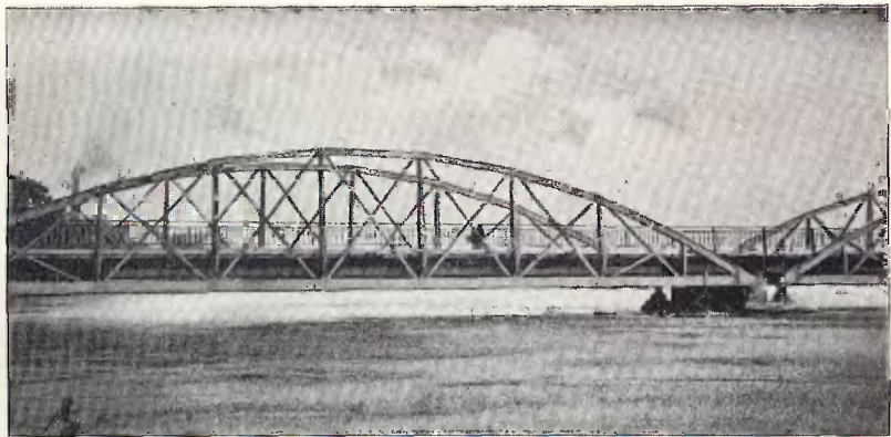
Erster Brückenbogen beim Julihochwasser 1903
