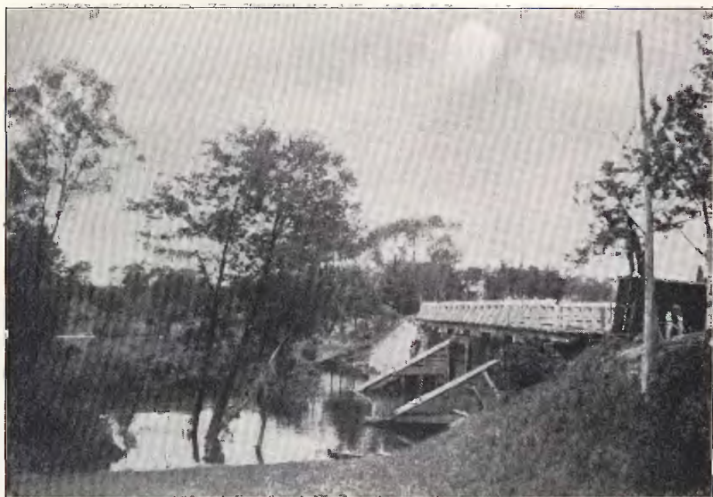
Alte Hohenplotzbrücke nach dem Julihochwasser 1903
