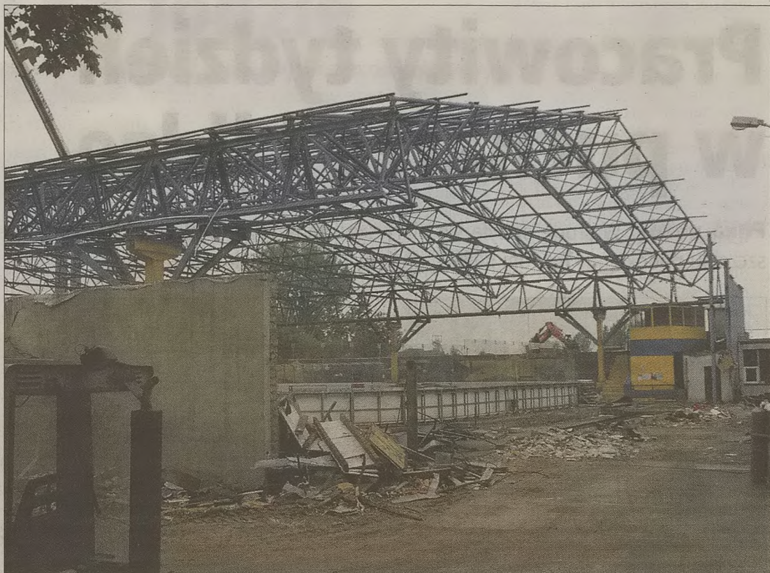
Hala musi zniknąć do 15 października
