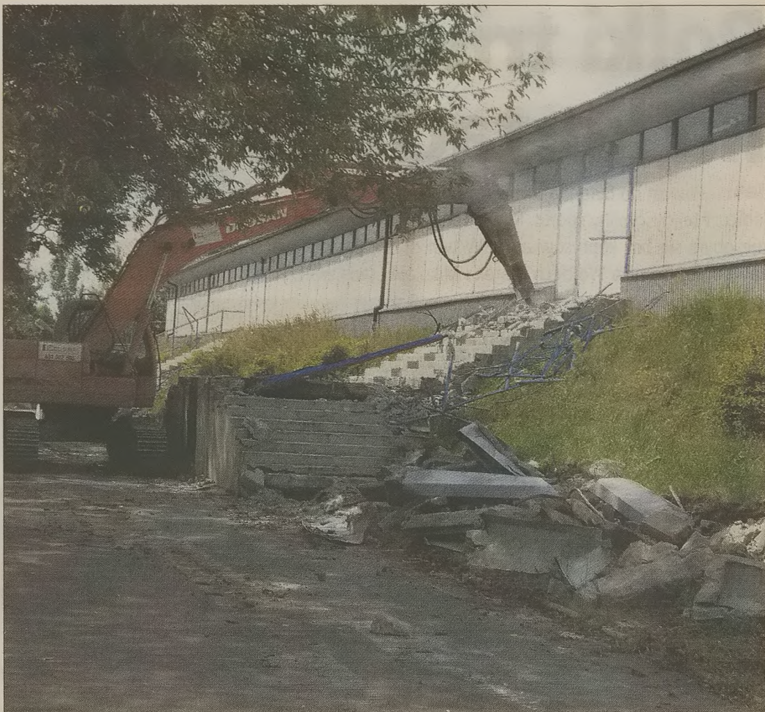
Machina z hukiem kruszy starą konstrukcję. Szybko zmienia się widok obiektu, do którego przyzwyczailiśmy się przez kilkadziesiąt lat
