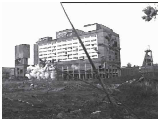
Likwidacja budynku płuczki
