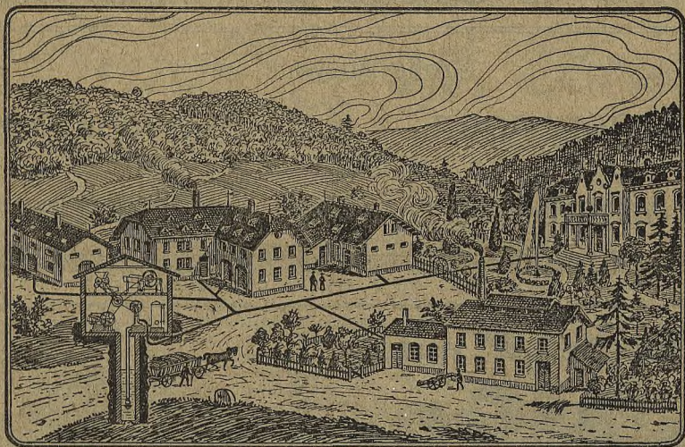
Wasserversorgung eines Gutshofes.
