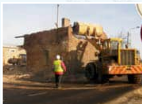
Rozbiórka domu w Sadowie - str. 3
