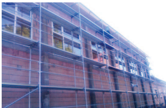
Trwają prace nad budową hali sportowej w Rusinowicach.
