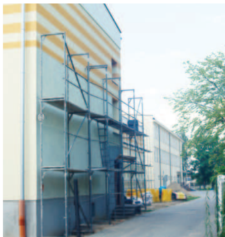
Do końca września potrwać prace nad termomodernizacją budynków Zespołu Szkół i Domu Kultury w Strzebinie.
