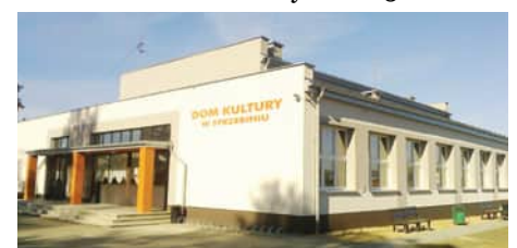
Zespół Szkół i Dom Kultury w Strzebinie przeszły kompleksową termomodernizację.
