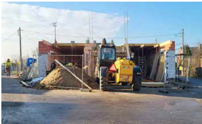
Lubieszów - przebudowa remizy OSP
