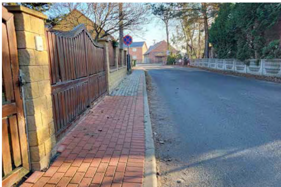
Stare Koźle - modernizacja chodnika
