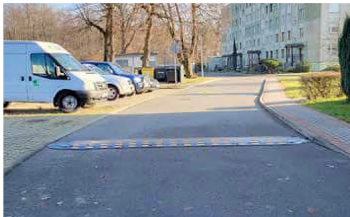
Kotlarnia - montaż progu zwalniającego
