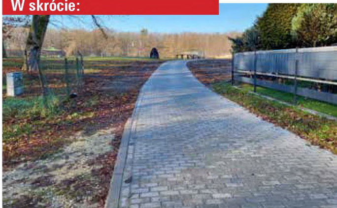
Korzonek - remont drogi dojazdowej do garaży
