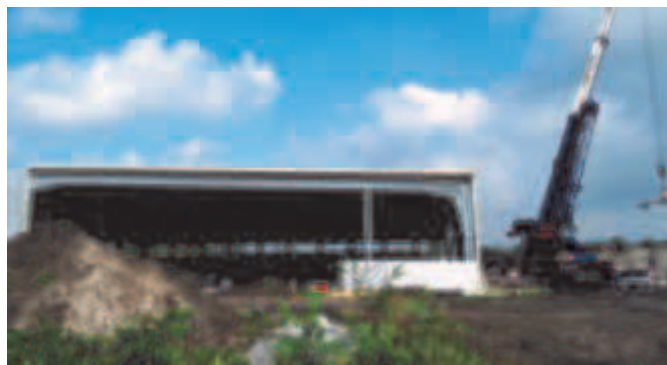
Budowa hali produkcyjnej (fot. B. Kozina)
