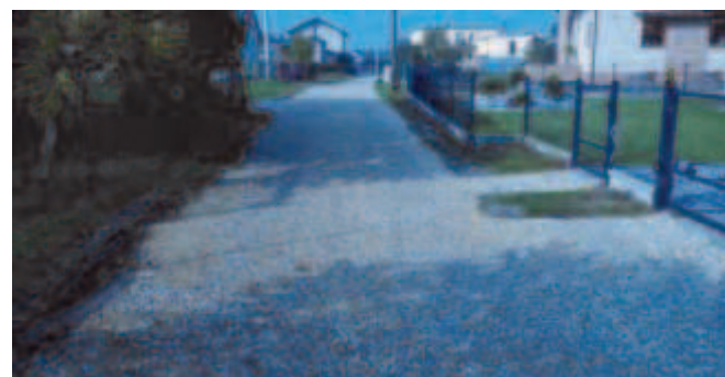
Utwardzenie drogi gminnej w Siedliskach (ul. Młyńska) kruszywem dolomitowym. Jest to przygotowanie pod nawierzchnię asfaltową Fot. UM Kuźnia Raciborska
