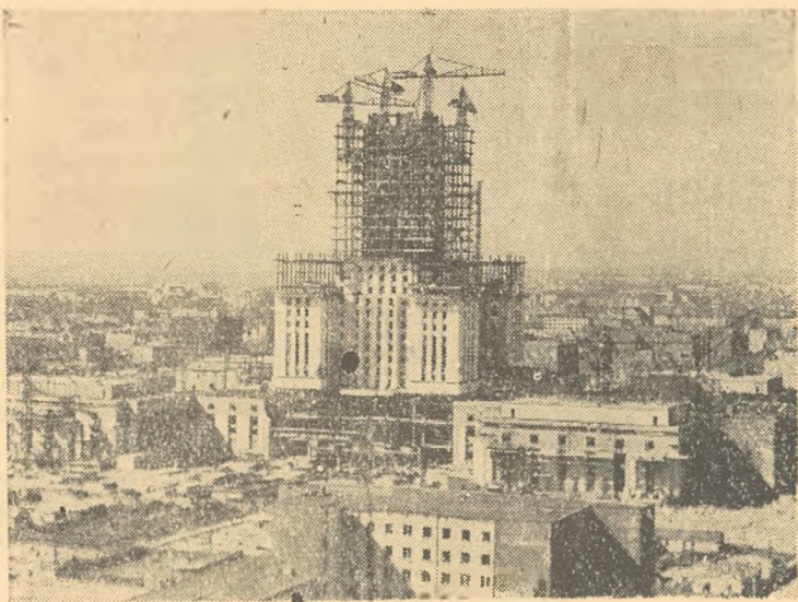
Warszawa coraz piękniejsza. Na zdjęciu budowa Pałacu Kultury i Nauki im. J. Stalina.
